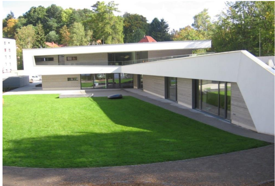
Kindertagesstätte Oberlinhaus erstes stadt-eigenes Plus-Energie-Gebäude Wärmeversorgung mit Wärmepumpe
