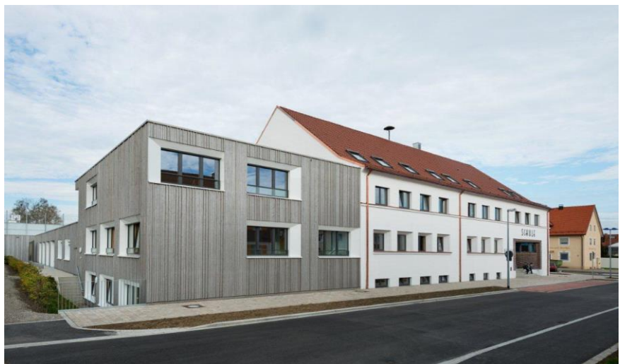
Generalsanierung der Grundschule Kottorn/Eich Neubau im Passivhausstandard Wärmeversorgung mit Pelletkessel
