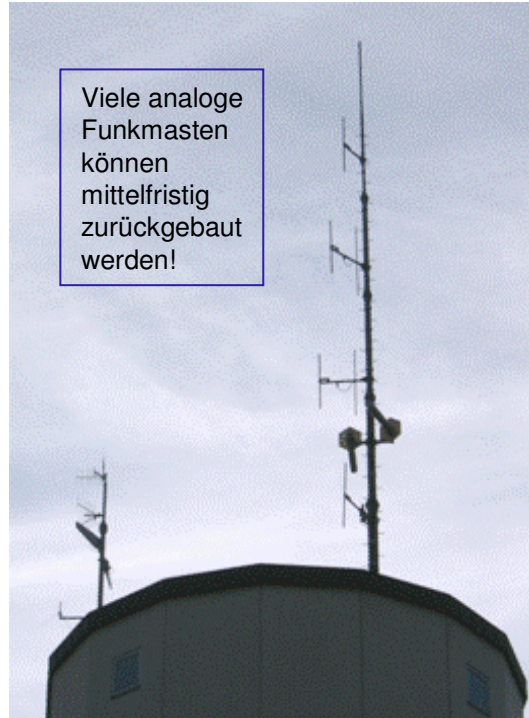
Wasserturm Obertunding: Analoge Funkstellen der BOS
